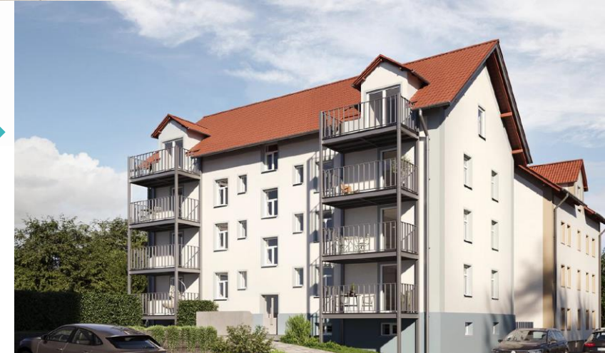
Außenansicht eines unserer Denkmalobjekte am Bodensee →
